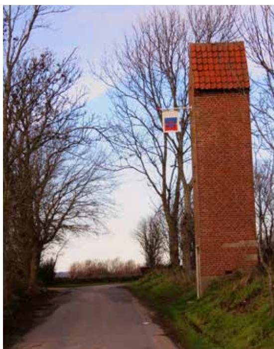
Det nedlagte transformertårn - nu kunsttårn - på Langøvej.
