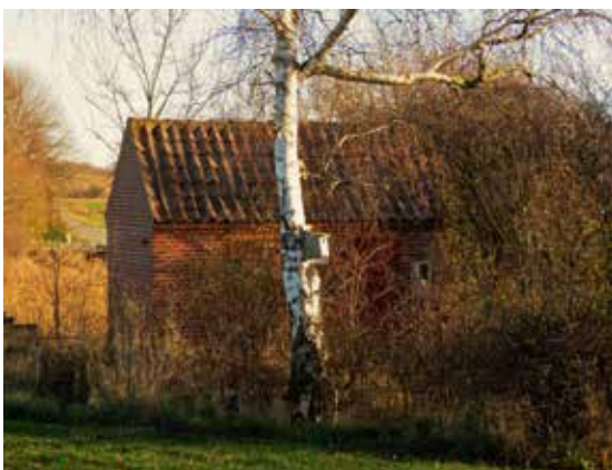
Pumpestationen ved Bogøvej 23.
