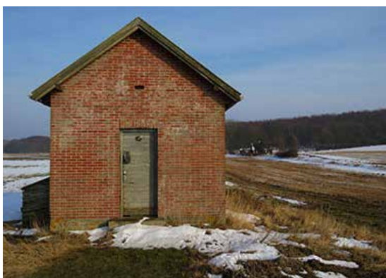
Et typisk pumpehus syd for Korsebøllevej.
