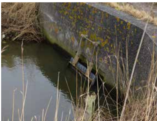
Højvandssluse ved Egeløkke, som sikrer, at vandet ikke trænger ind fra Langelandsund.
